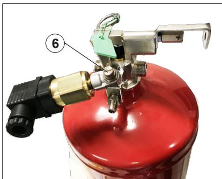
2. Recarga y presurización del extintor: proceder a recargar el extintor y presurizar el extintor a 10 bar a 20°C de acuerdo con el procedimiento "Operaciones de llenado y presurización del extintor FireKill cargado con HFC227".
